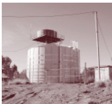
New 486 KL Nyirripi tank.
